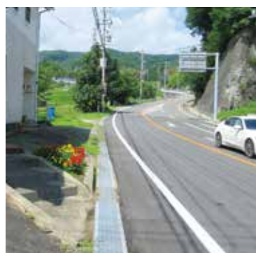
松原湖駅南口上り線バス停付近 歩道が無く危険
