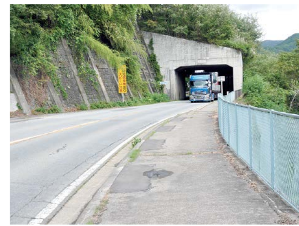
鎚掛洞門前の歩道
