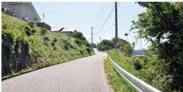
道路改良工事予定地
