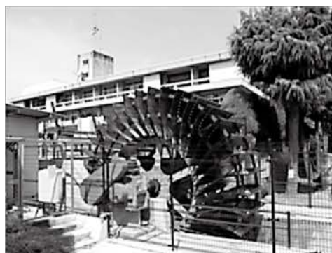
山梨県都留市 小水力発電所
