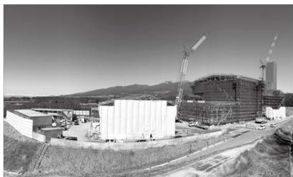
佐久市に建設中の新クリーンセンター
