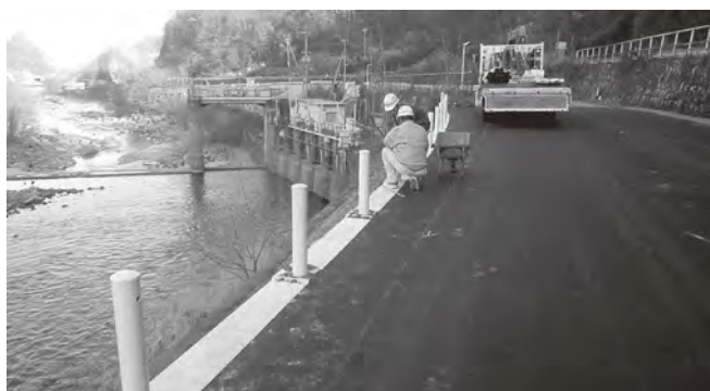
道路拡幅工事により2車線になった県道川上佐久線
