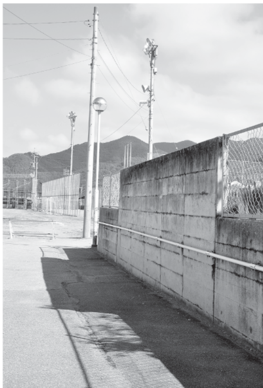
北牧楽集館コンクリート塀
