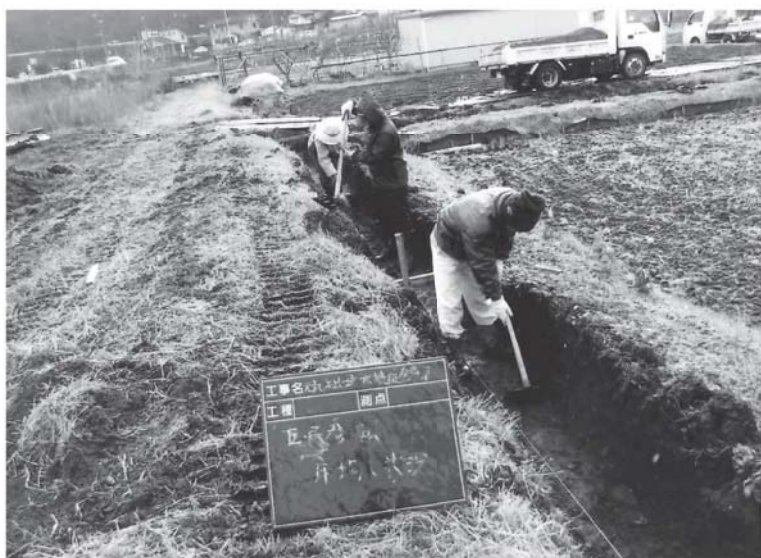
集落再生支援事業を利用した本間地区水路改修作業
