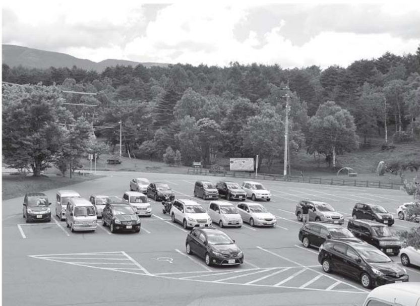
改善が必要とされる八峰の湯駐車場
