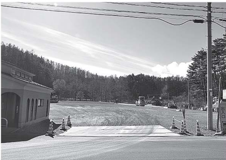
高速道路の残土を埋め立てている松原湖町営駐車場
