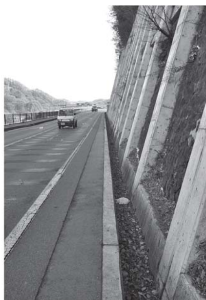
国道141号線の側溝
