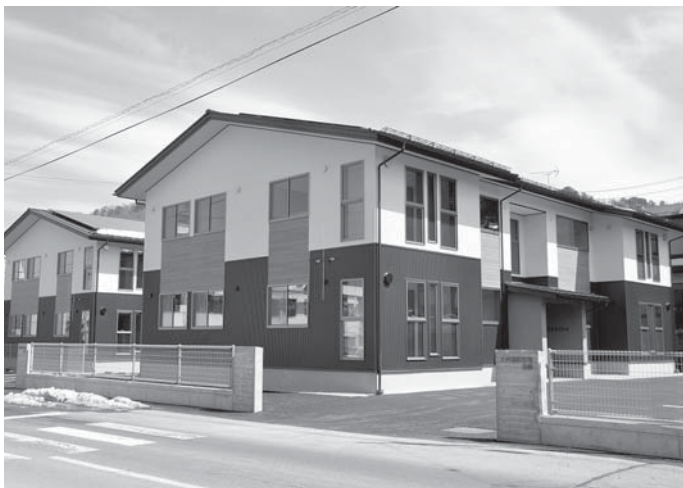
完成した南町町営住宅
