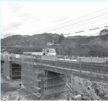
工事中の箕輪橋
