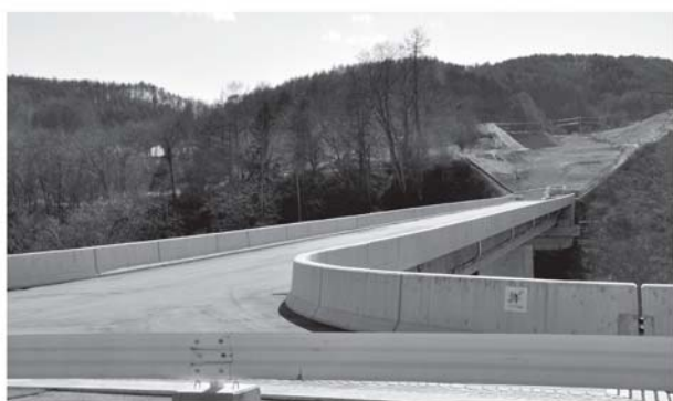
平成29年供用開始に向け建設が進む(仮称)八千穂IC
