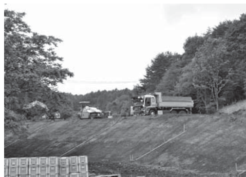
工事が進む広域農道建設現場
