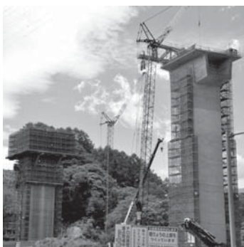
着々と工事が進む中部横断自動車道
