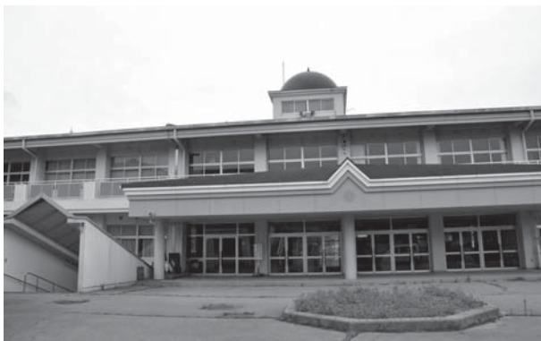
学習館として新たに活用される旧北牧小学校校舎
