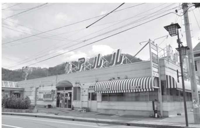
小海駅舎ショッピングセンターアルル
