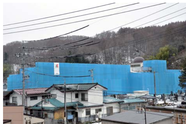
改修工事が進む（仮称）北牧学習館
