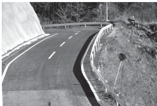
今年度改良工事が実施された町道大洲除ヶ線
