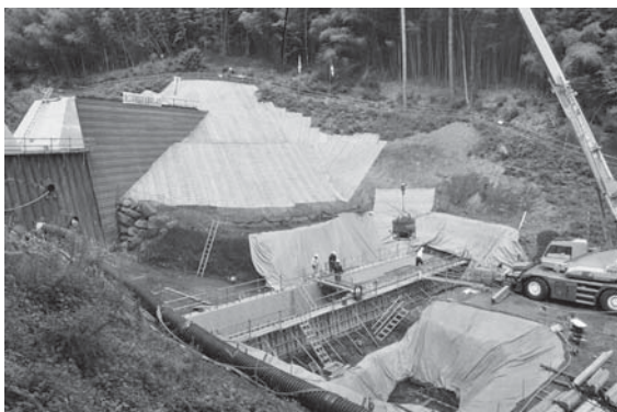
着々と工事の進む馬流砂防堰堤工事現場
