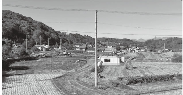
造成工事の様子
