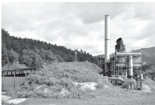
旧小海リサイクルセンター
