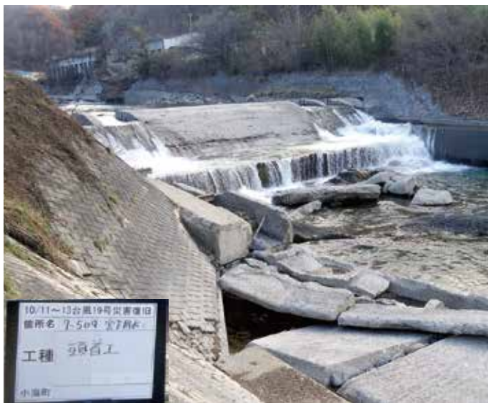
宮下水頭首工 右岸側より
