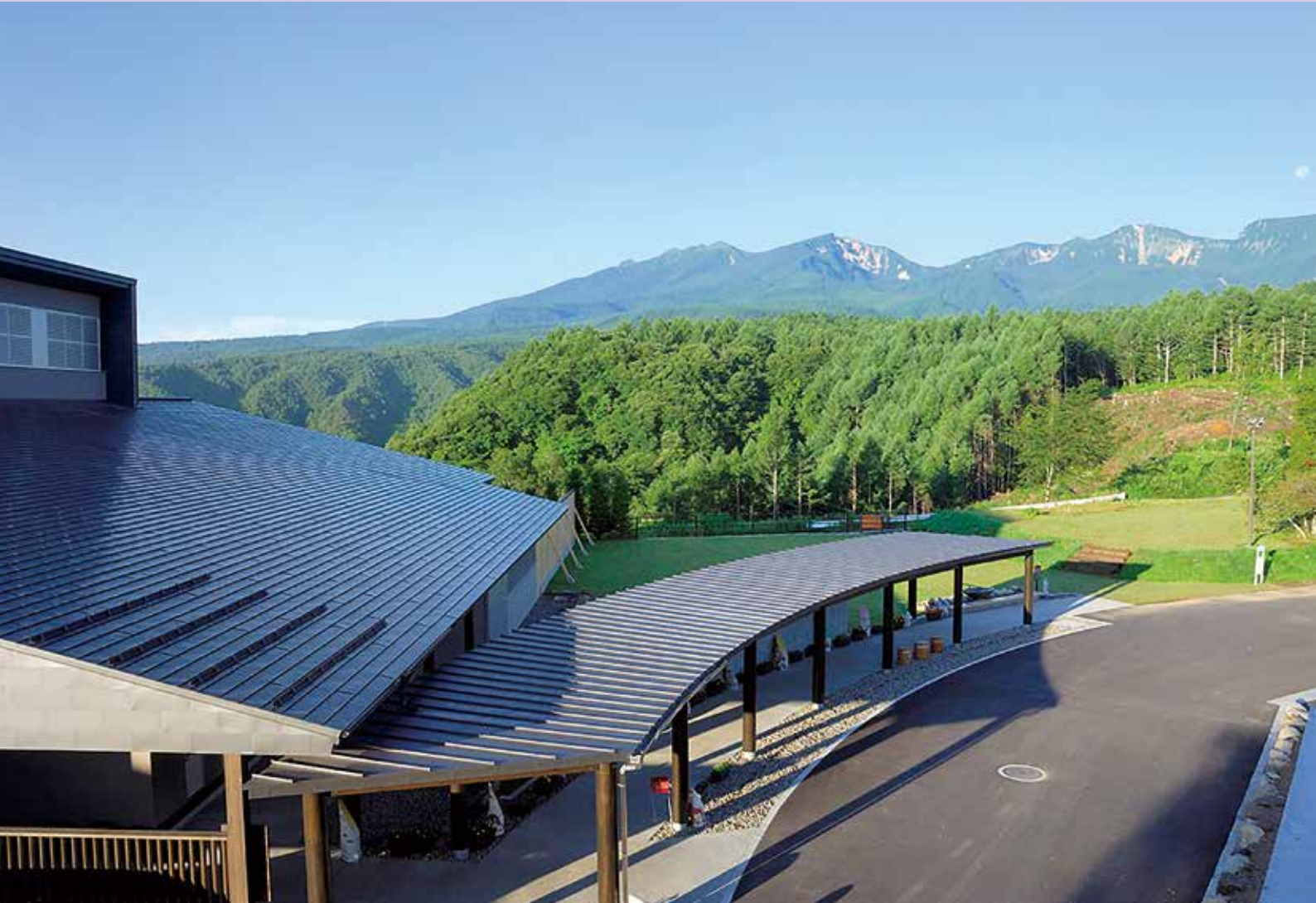
改修工事予定の八峰の湯
