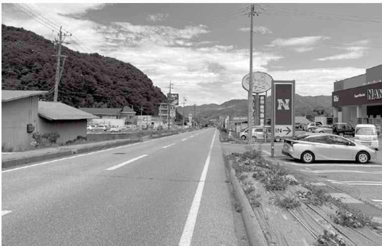
国道141号 福山地籍
