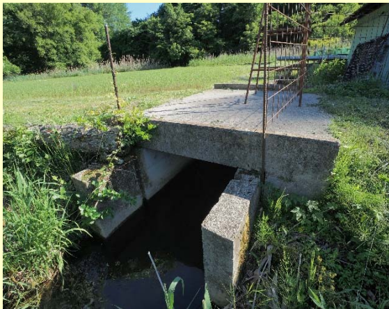
健全度 I : 芦平枝1号橋
