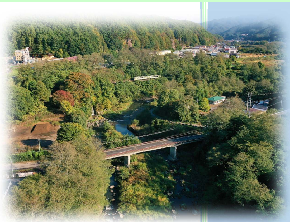
箕輪橋 3径間RC T桁橋
