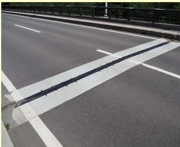
写真. 橋面補修例(小海大橋)
