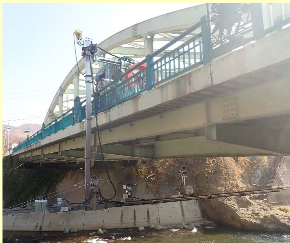
橋梁点検支援ロボット
