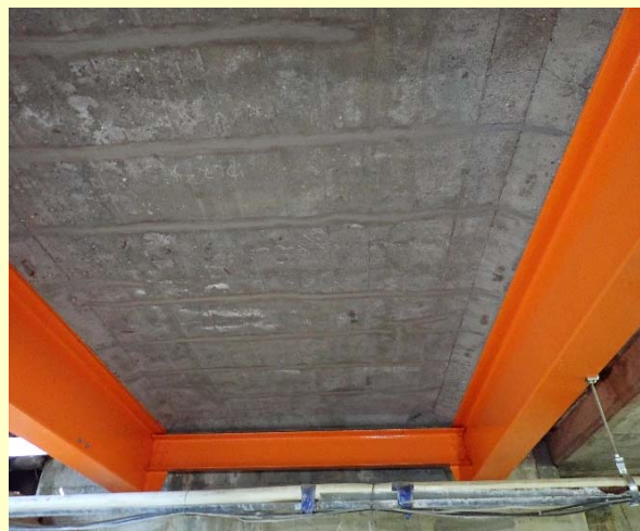
写真. 主桁・床版補修例(嘘沢橋)
