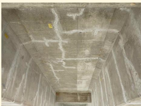
写真3. 主桁・床版補修例 **箕輪橋**
