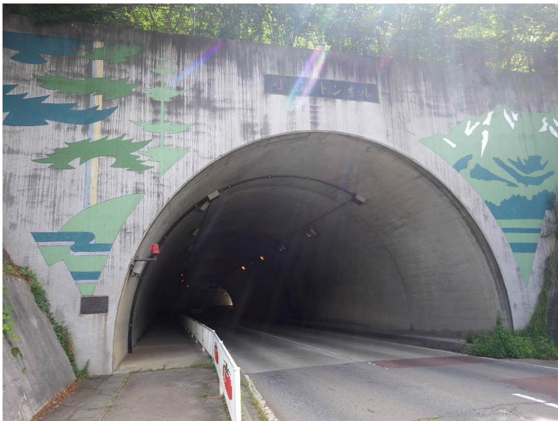
町道 鎰掛・土村線 小海トンネル
