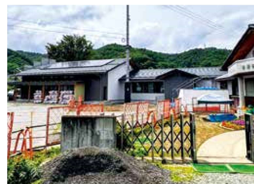
増築工事中の児童館
