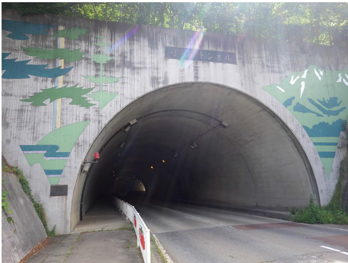
町道 鎚掛・土村線 小海トンネル
