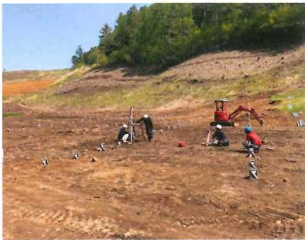
②基礎工事
