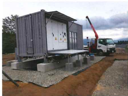
⑤PCS/受変電設備据付
