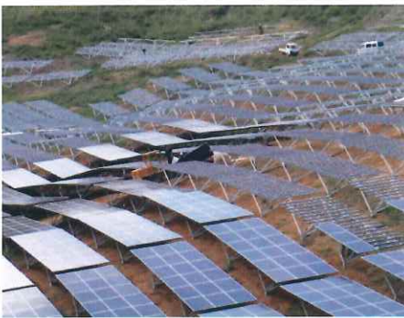
④パネル設置
