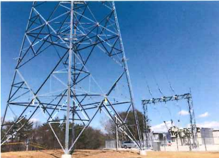
⑥連系変電所工事
