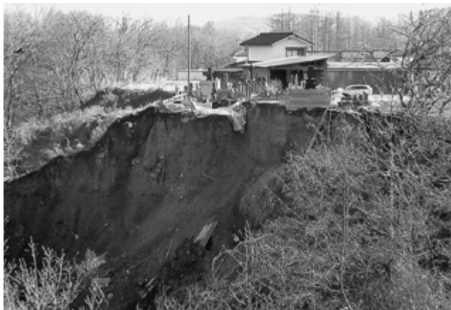
土砂崩落の規模 幅20m 高さ35m 大月川に幅50mに渡り土砂が堆積
